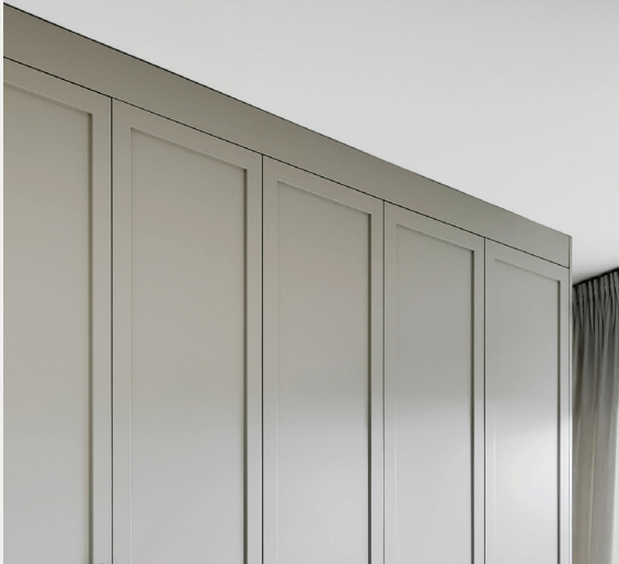
Takanslutning i nivå med luckor
